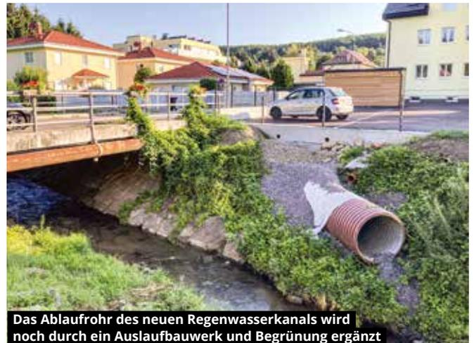
Das Ablaufrohr des neuen Regenwasserkanals wird noch durch ein Auslaufbauwerk und Begrünung ergänzt
